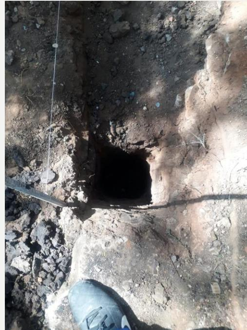
Escavação das brocas de fundação do muro de arrimo mais montagem da armadura estrutural.
